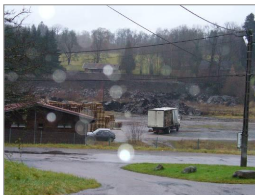
Dysfonctionnement paysager important sur l'ancien site de la fabrique de la Glacerie.
