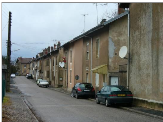
Cités ouvrières rue du Lavoir.
